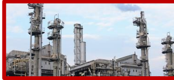
Abwärmenutzung i. therm- ischer Nachverbrennung
