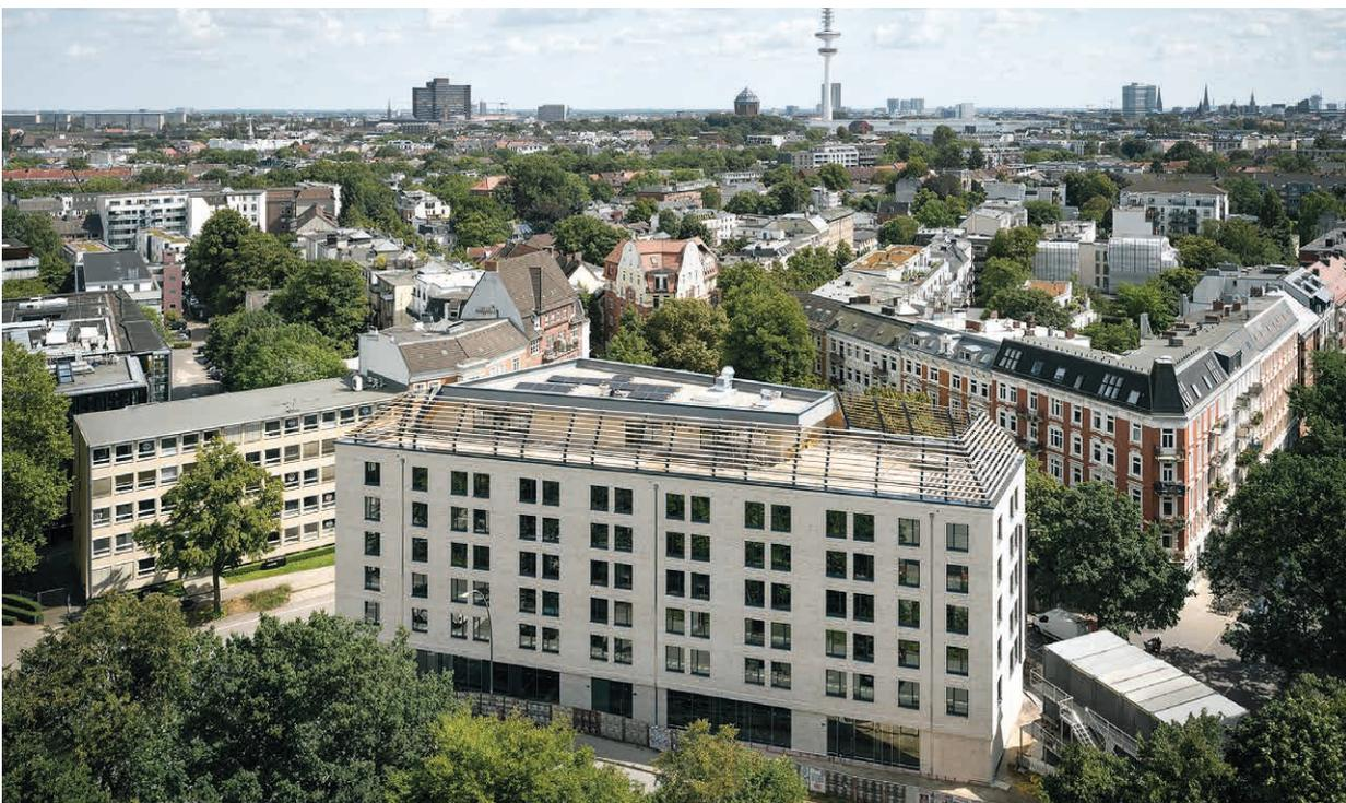
Klinker aus recyceltem Material, Photovoltaikanlage zur Stromerzeugung und eine begehbare Dachterrasse – die Haspa setzt auf eine hochwertige und nachhaltige Gebäudeplanung.
